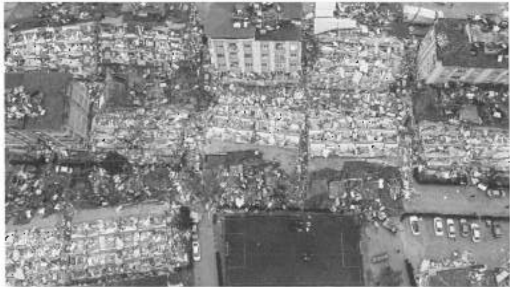
Рис. 3. Последствия землетрясения в Турции в 2023 г.
